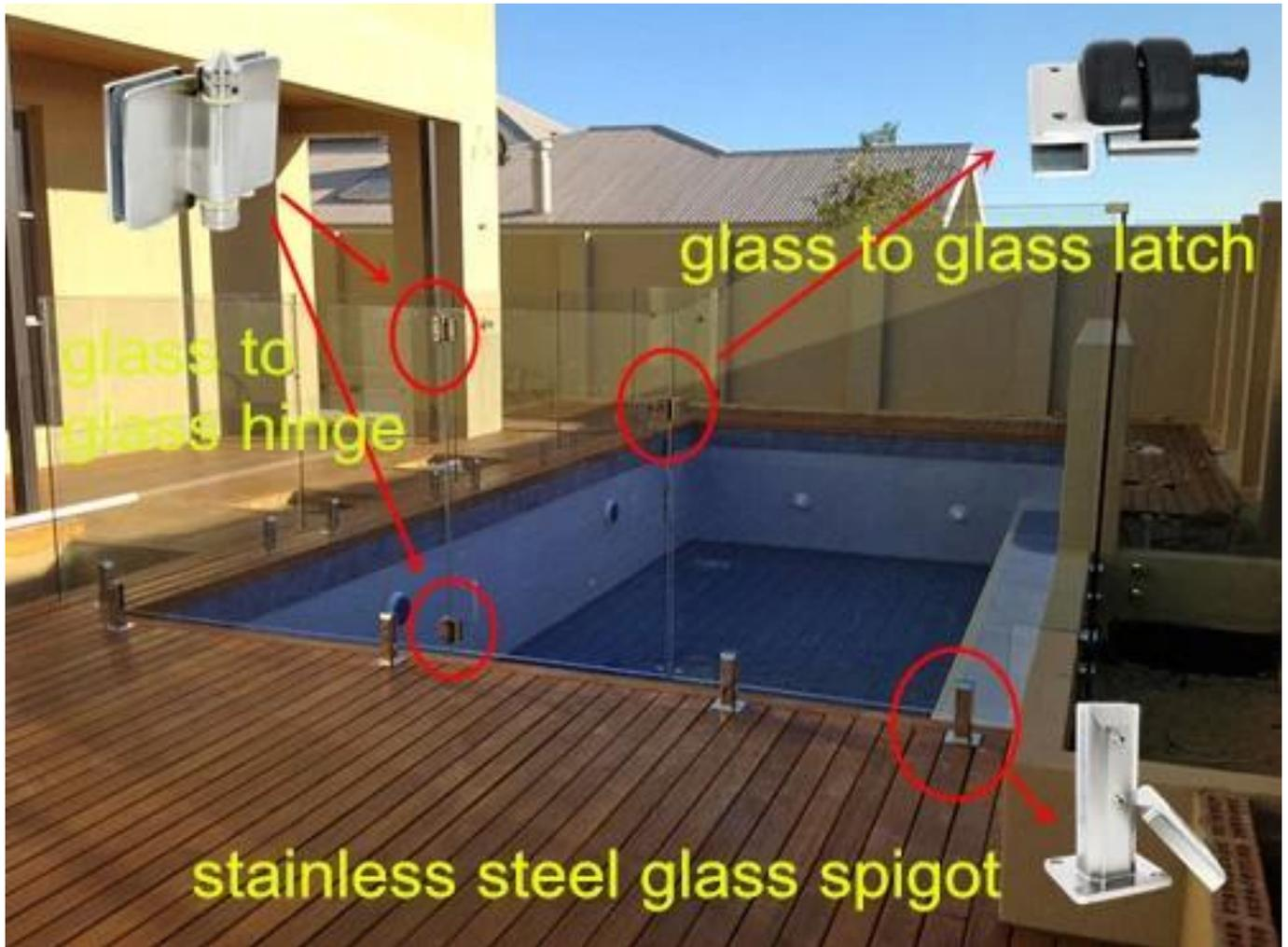
[China Gate vetro fornitore acciaio inox AISI 316 cerniere di istruzioni installa.](#)
