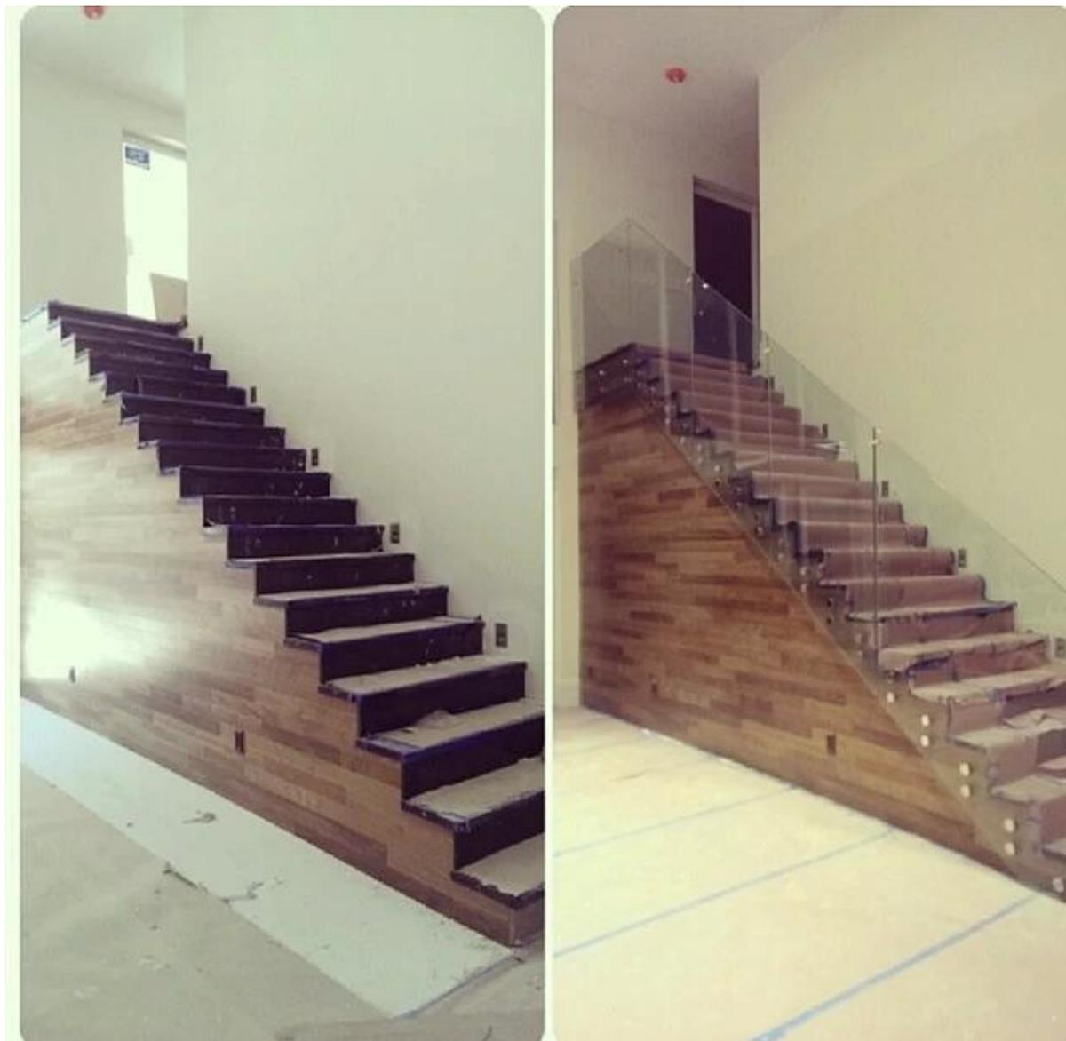
Stallo normalmente vetro è utilizzato per la progettazione senza telaio ringhiera di vetro, in ogni caso, se avete bisogno di aggiungere un corrimano superiore, il nostro mini slot superiore dovrebbe essere una buona scelta è il tuo bicchiere è di 12 mm;
