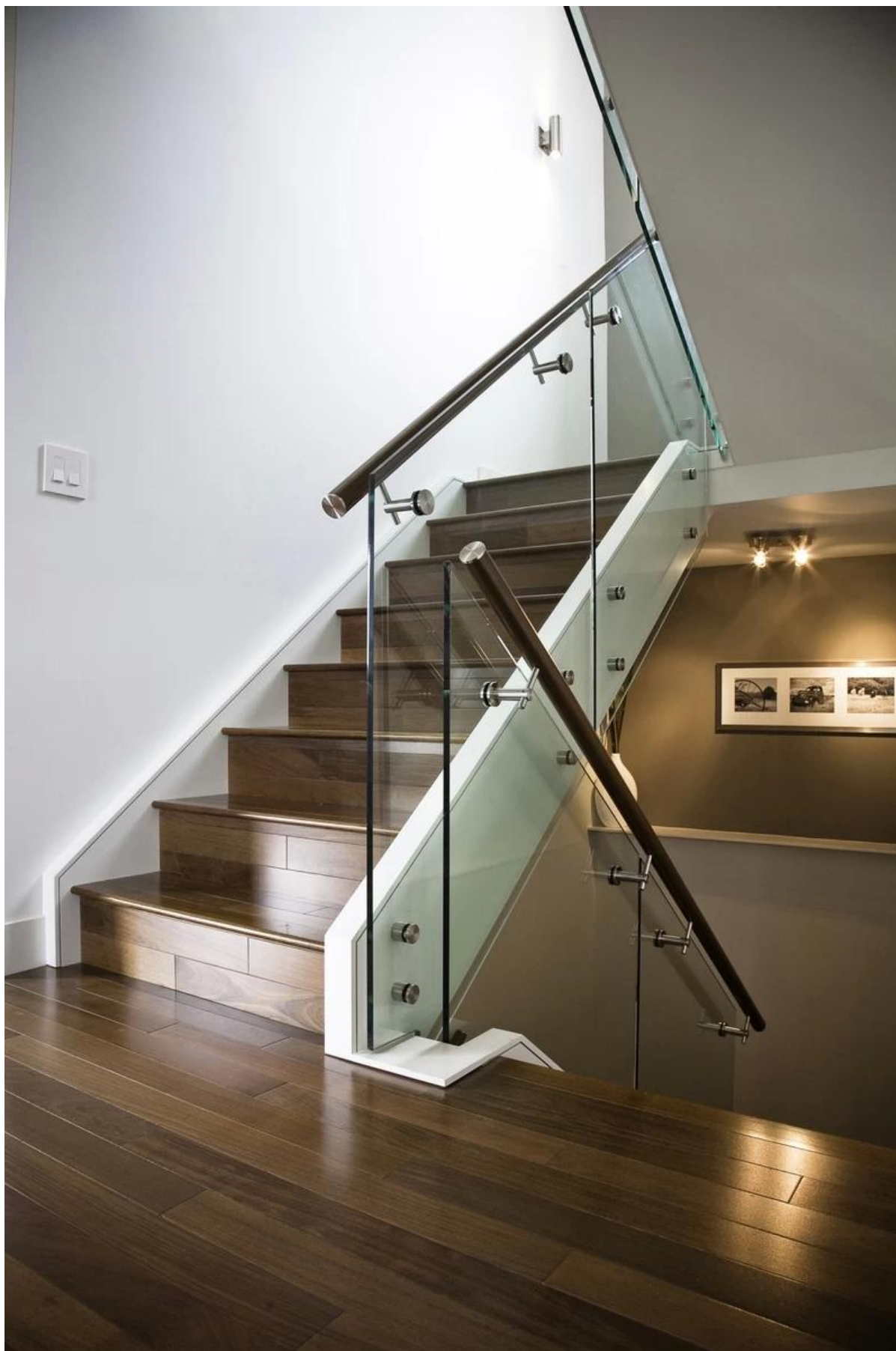
4). Modello No.P708 scalinata in vetro parete in acciaio inox staffa corrimano montato
