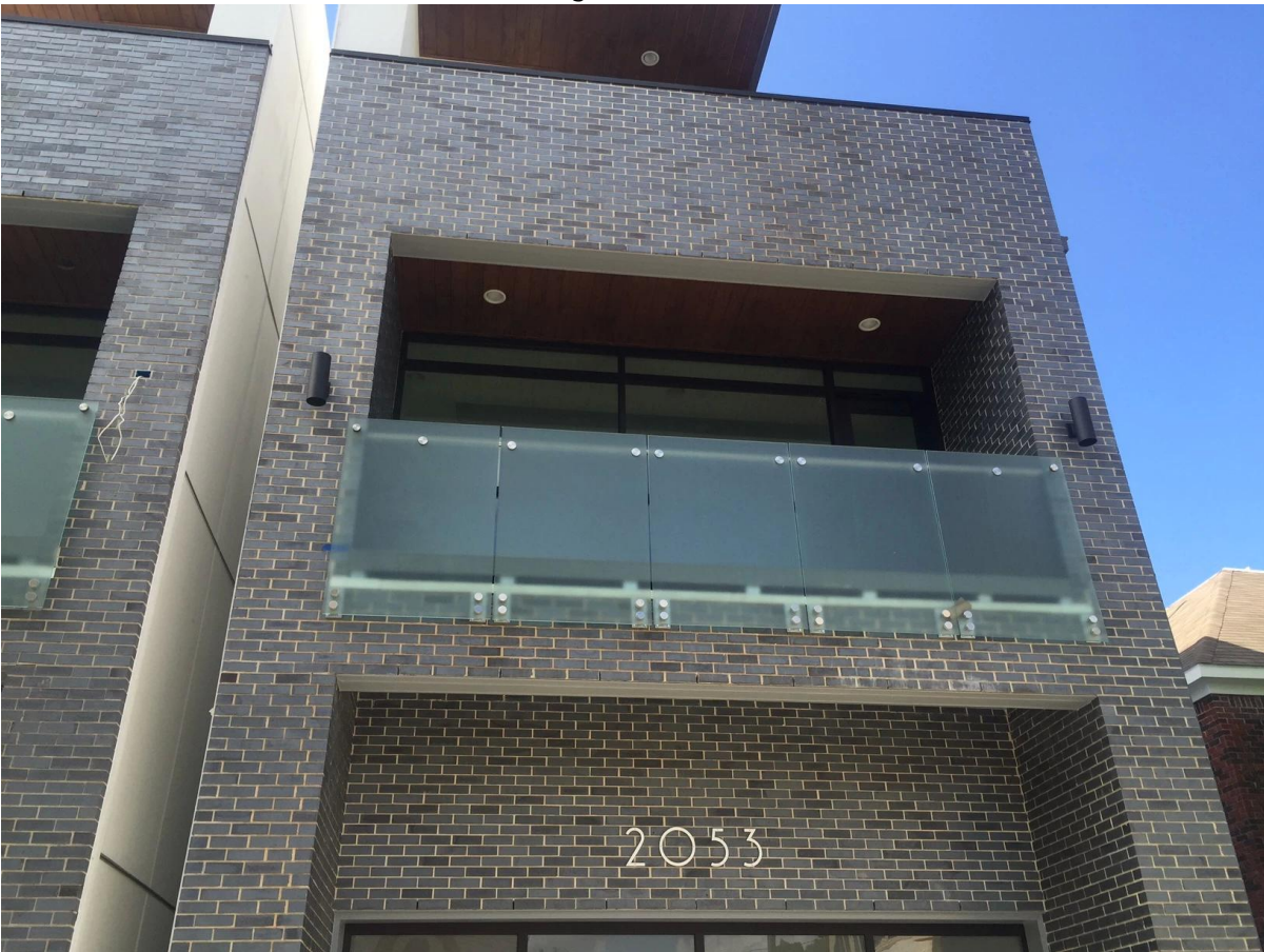
le foto di installazione di staffa stallo ringhiera di vetro
