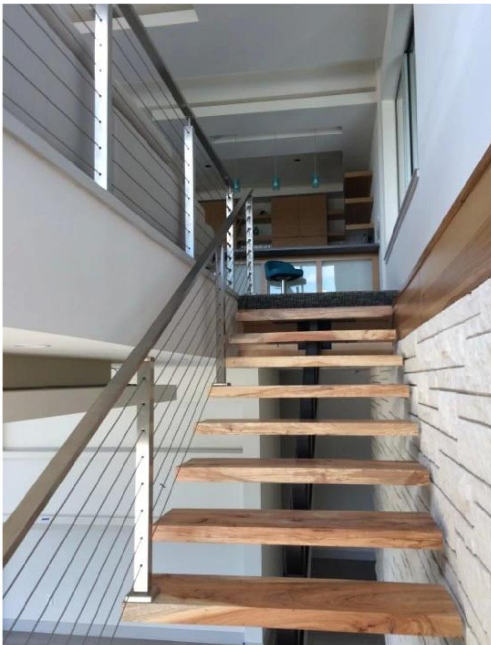
2. cavi di acciaio inox per interior scala di design in acciaio inossidabile fune ringhiera
