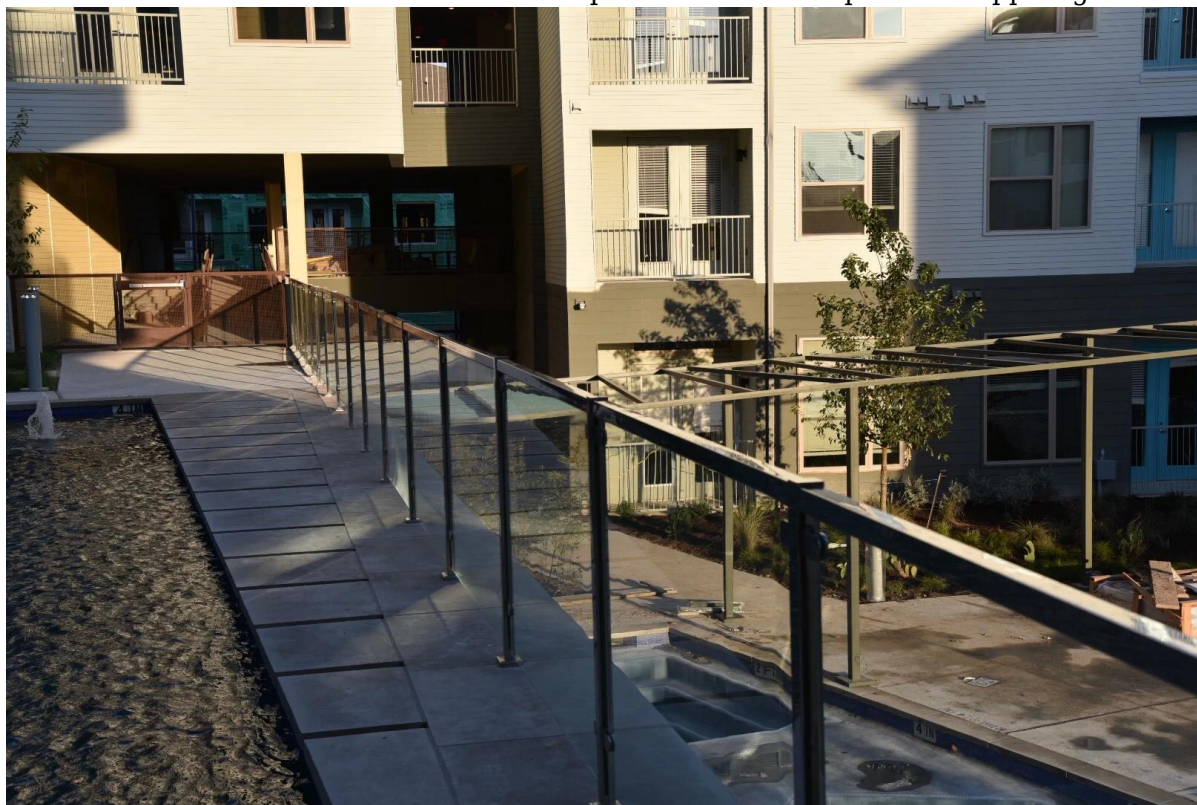
3. installazione-foto di acciaio inossidabile quadrati 80x80mm post con tappo sigillato
