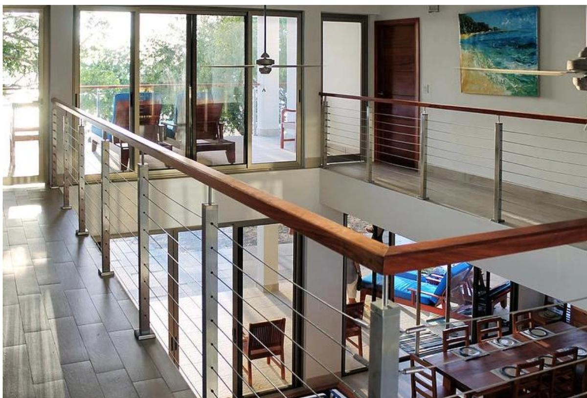
Immagine del sistema ferroviario corda di montaggio laterale filo con la parte superiore corrimano in acciaio inox:
