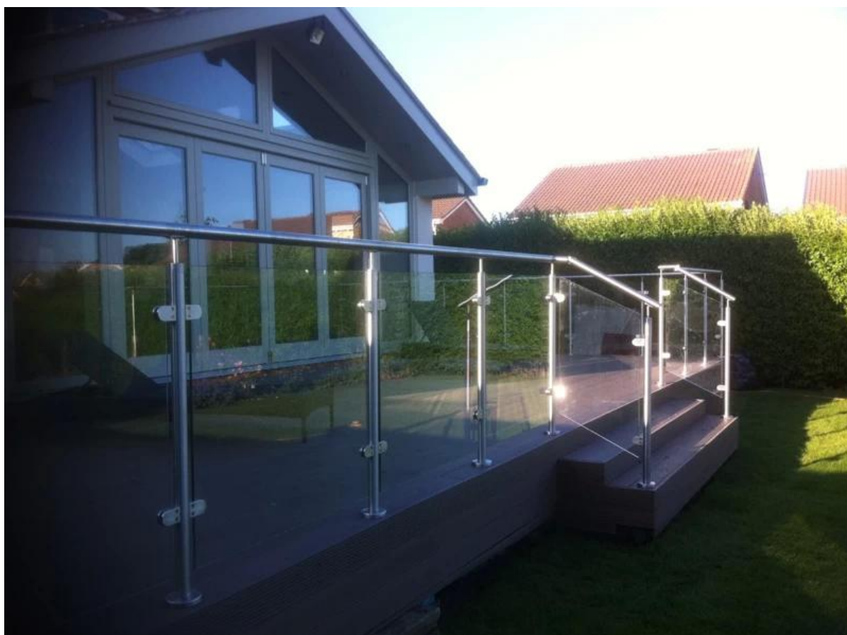
2) Semi-frame piattaforma esterna in acciaio inox disegno balaustra in vetro,
