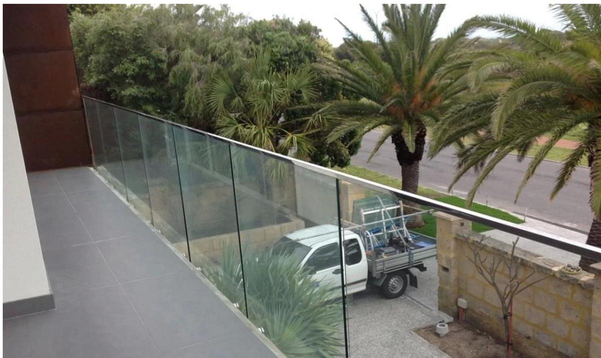
acciaio tubi di slot inox per frameless ringhiera del balcone, vetro supportato da [rubinetti di vetro](#)
