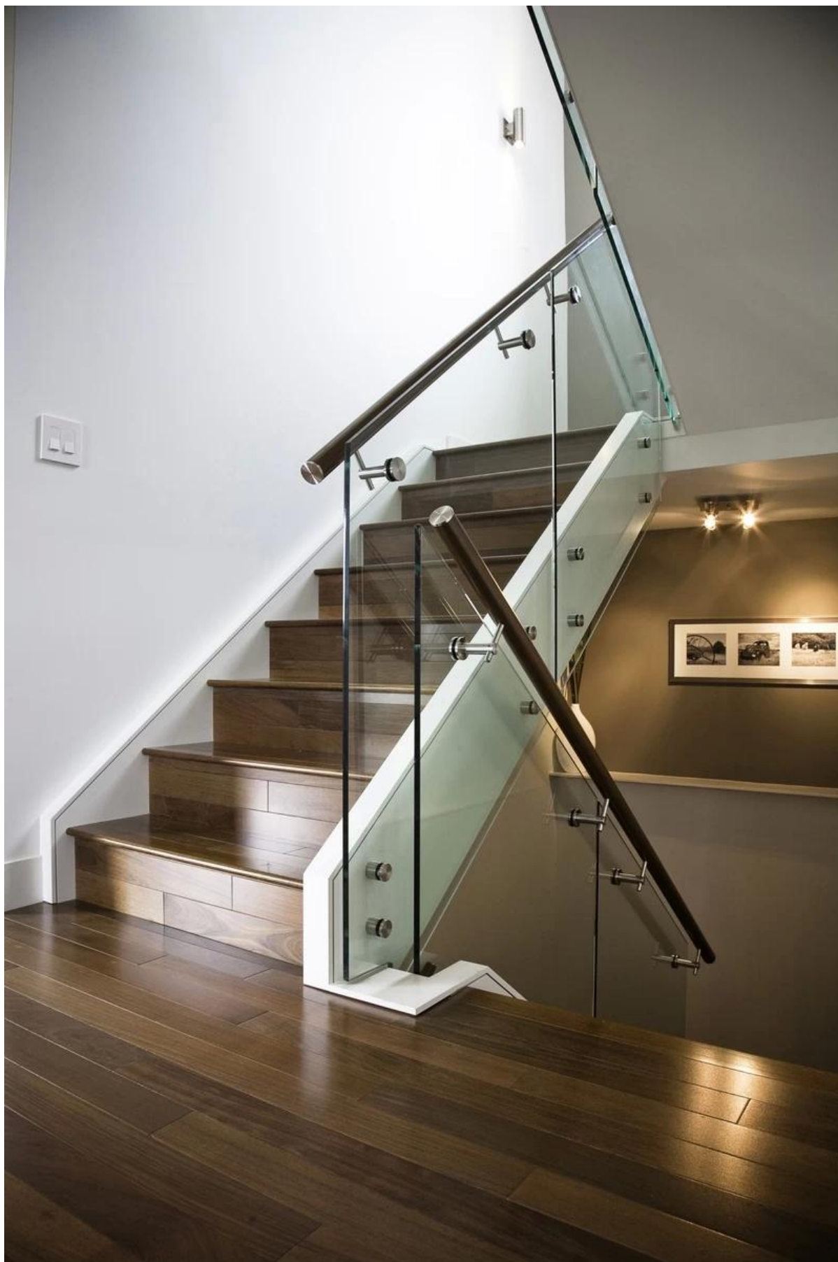
progetto di staffe di corrimano in acciaio inox fisso :
