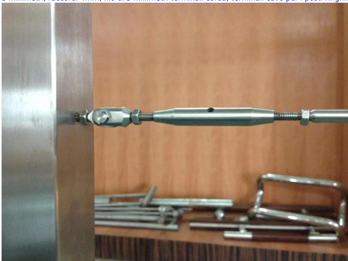
in acciaio inox filo coperta sistema di ringhiere di corda per la progettazione scale, inox304 / 316 ringhiera cavo con tensore cavo per scale e balcone
