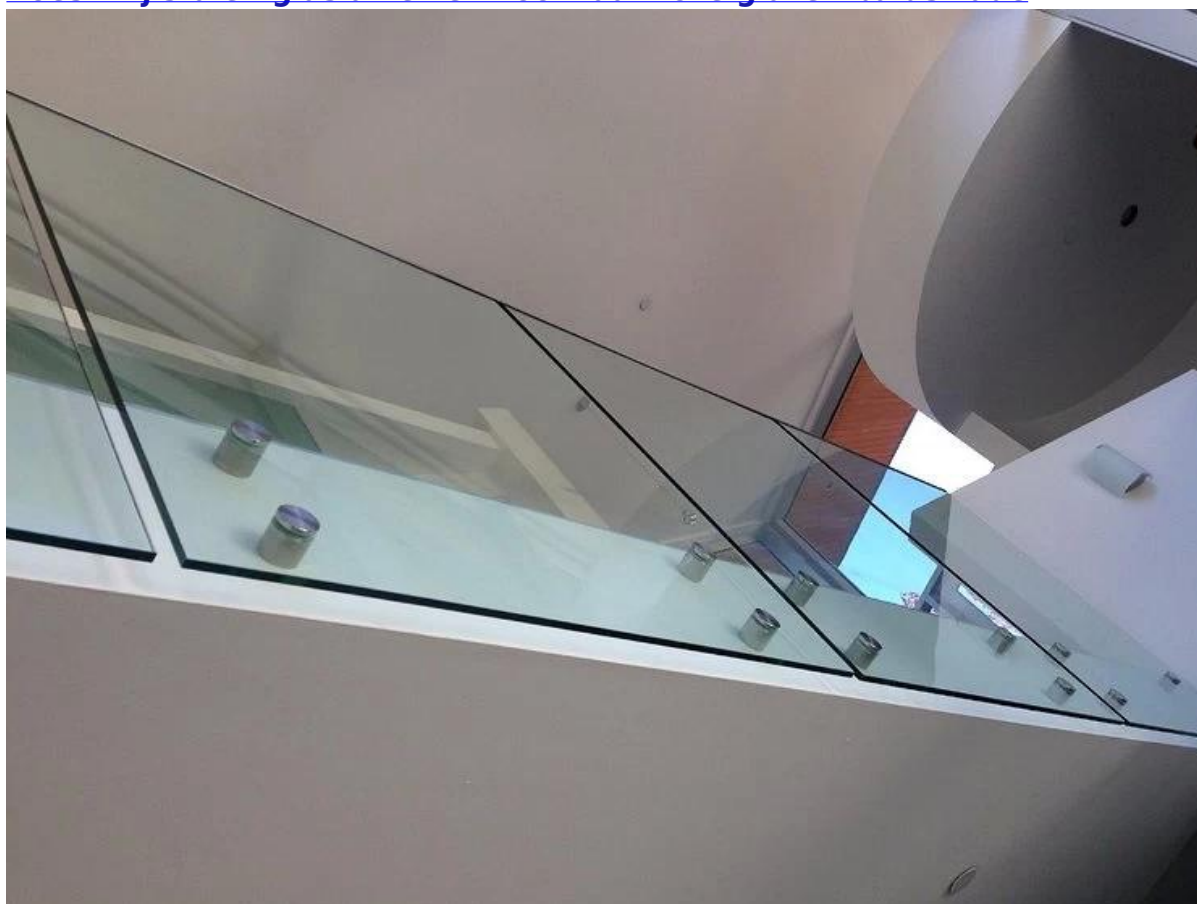
Roestvrij stalen glas afzetten voor raamloze glazen balustrade
