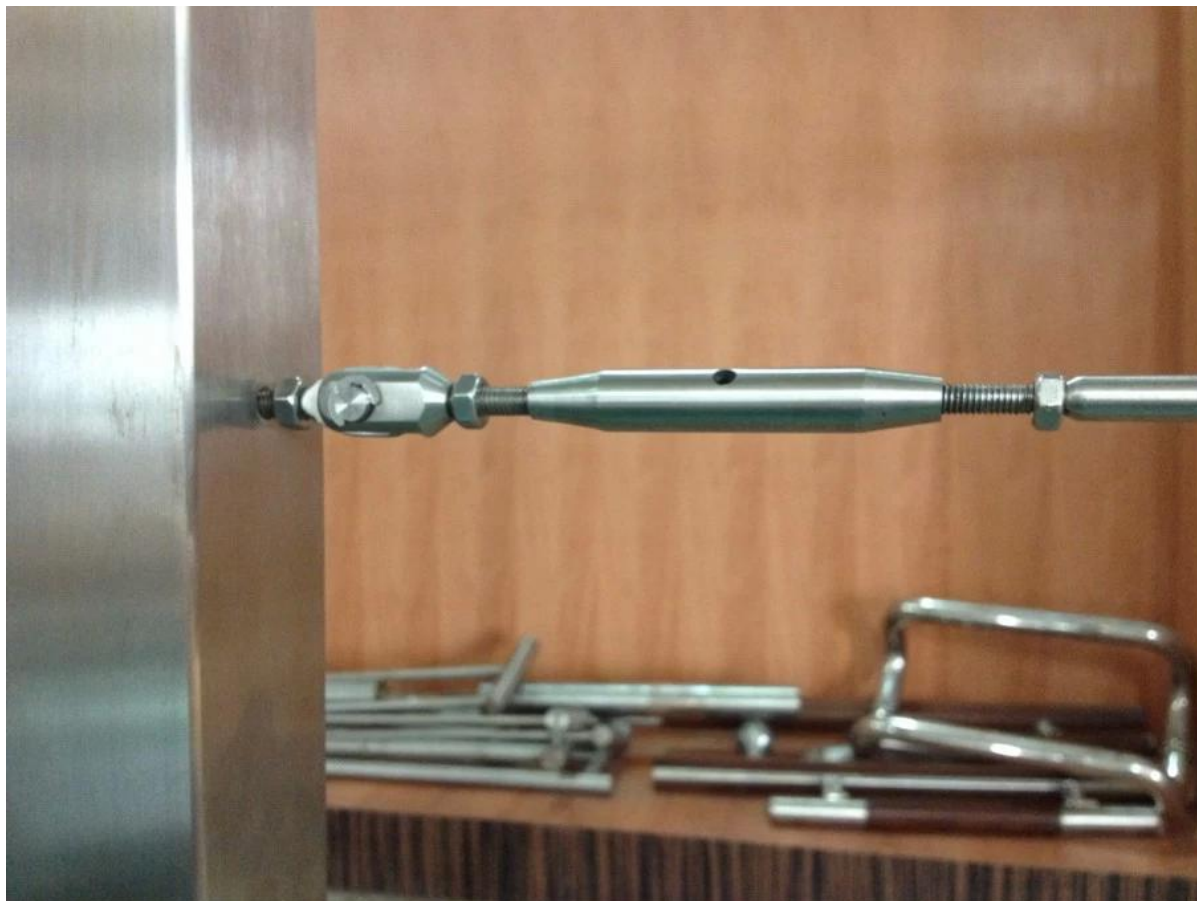
T804 staaldraadspanner bevestigd op hout -
