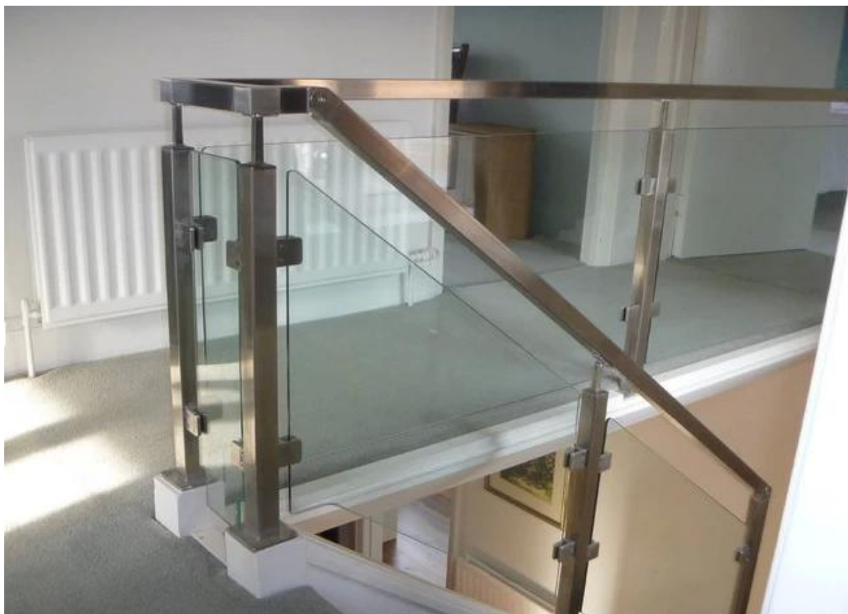
roestvrij stalen leuning, ronde terrasplanken post, glas metalen leuning voor de stappen
