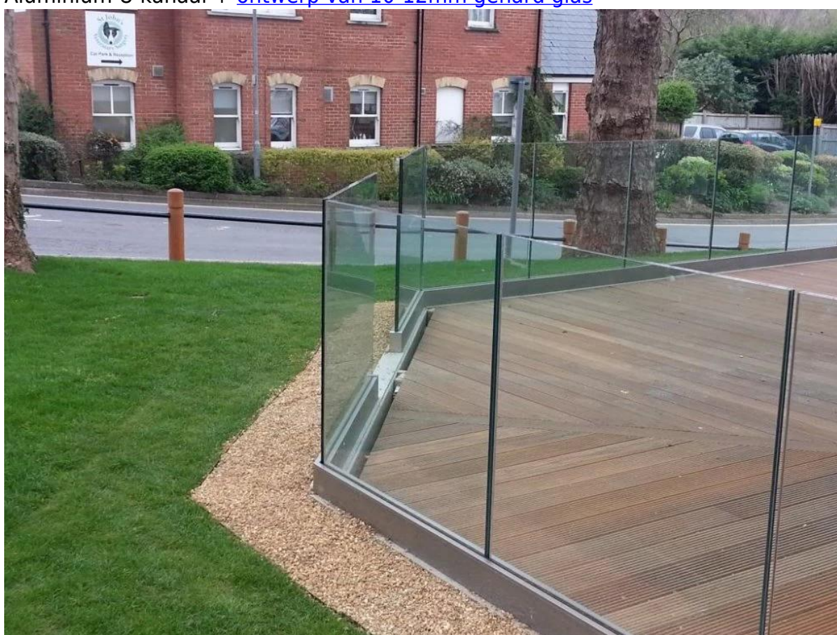
Aluminium U kanaal + ontwerp van 10-12mm gehard glas
