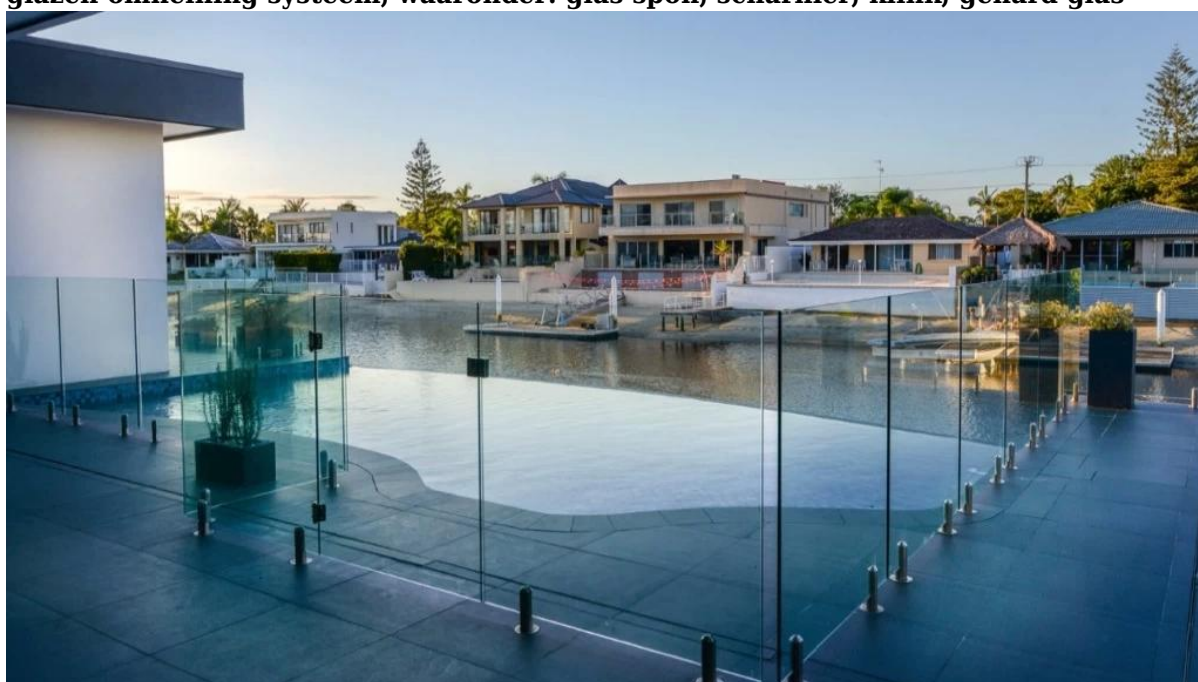
glazen omheining systeem, waaronder: glas spon, scharnier, klink, gehard glas
