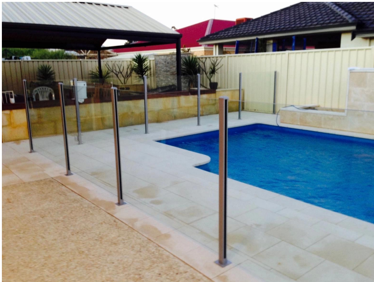
2) ronde frame-loze glas halve schermen aluminium post : diameter 50 mm x 3 mm
