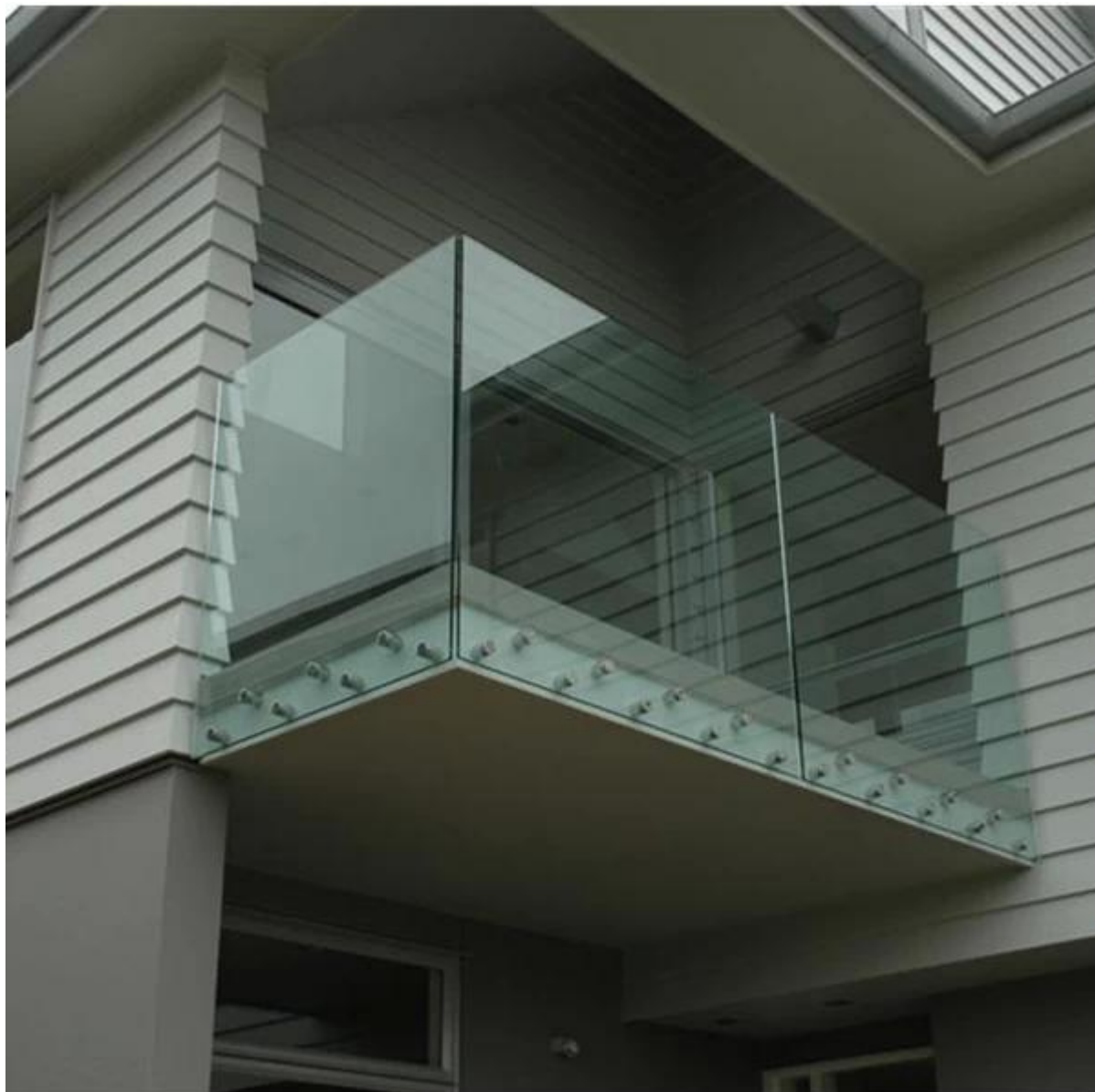
2.glass impasse beugel houten vloerafwerking
