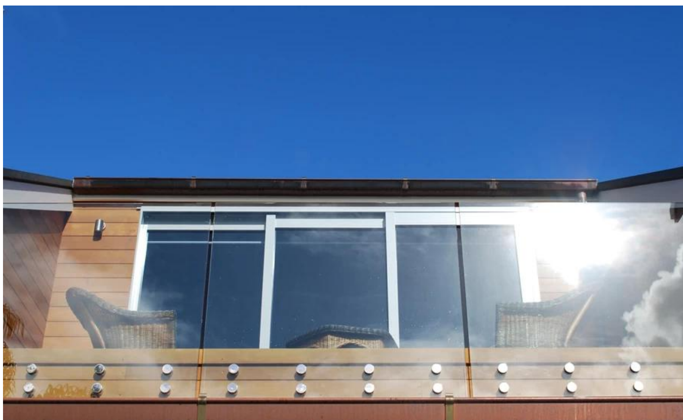
Installatie foto's van glazen balustrades
