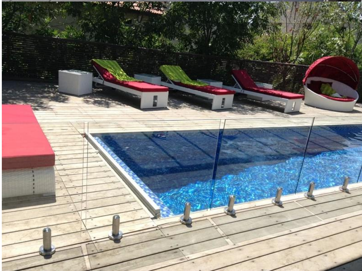
glazen balustrade met vierkante voetplaat glas spigot
