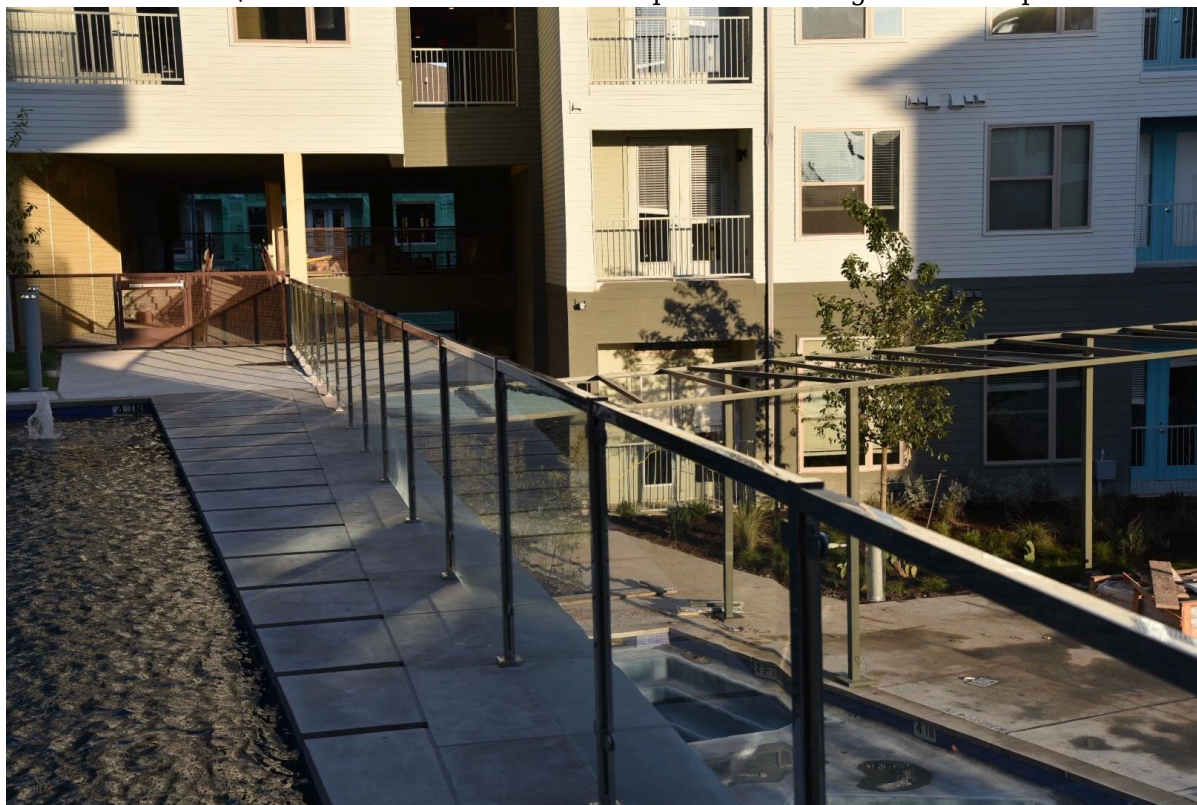
3. installatie foto's van RVS vierkant 80x80mm post met verzegelde eindkap
