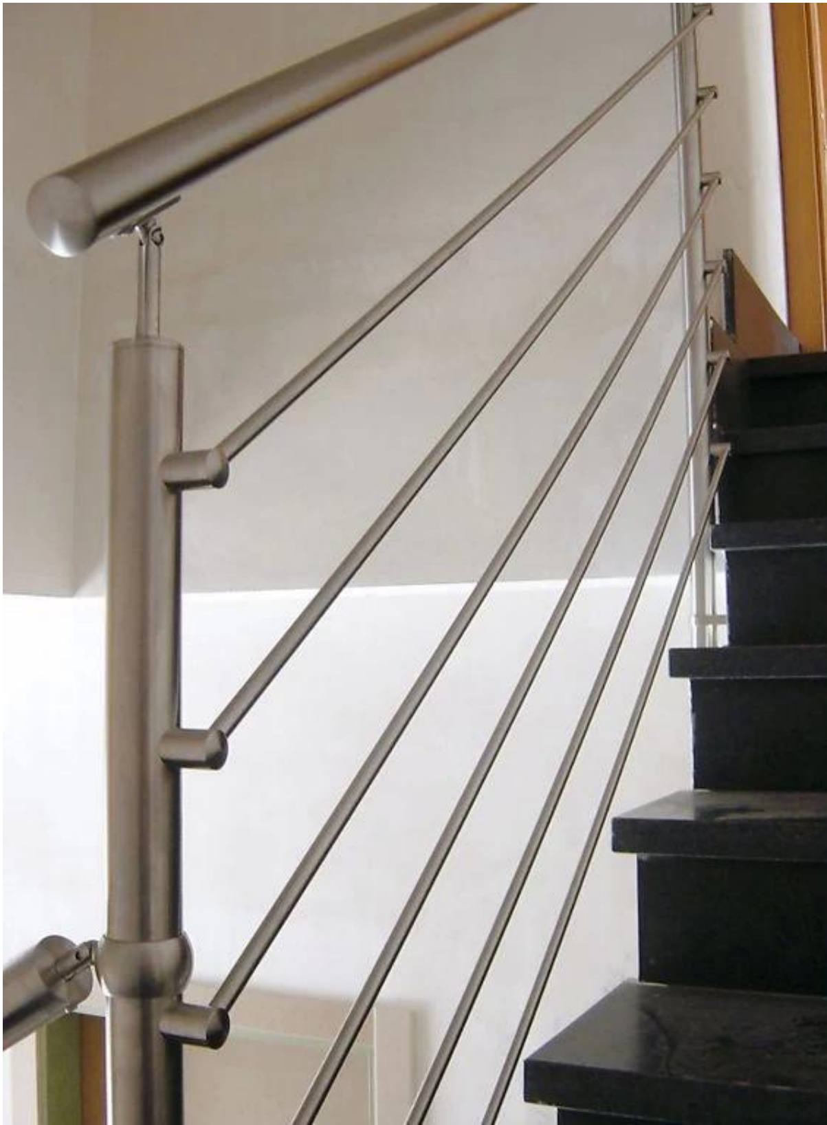
zijmontage dwarsbalk reling palen-
