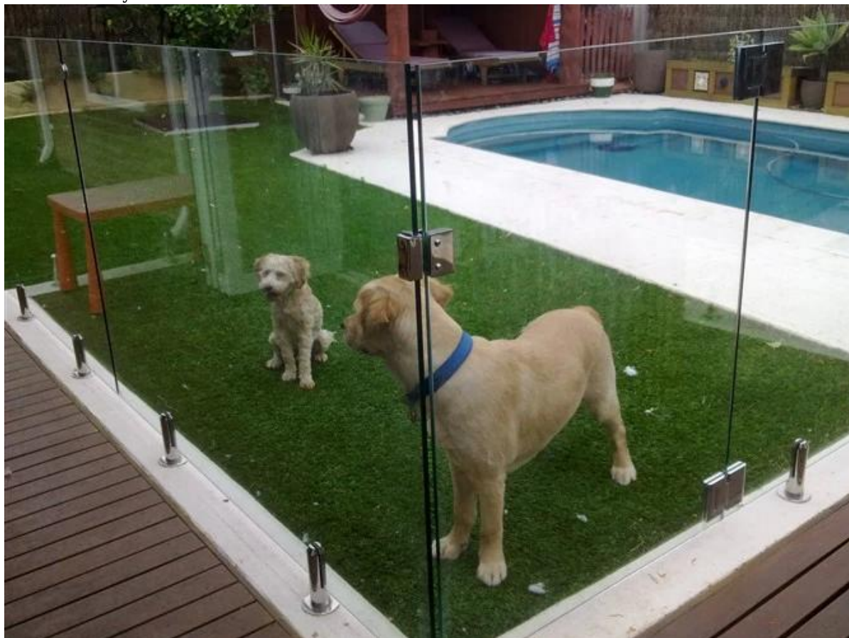
Aksesoria związane z klepiskiem szkła: Zawias szklany i zatrask:
