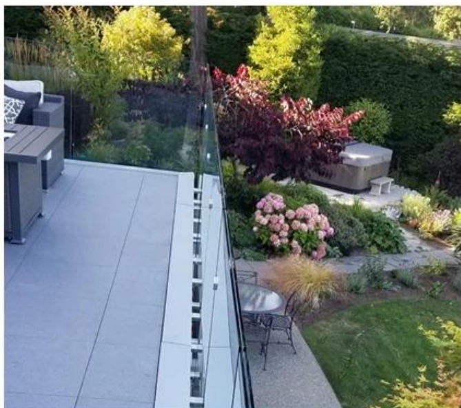
Stanik ze stali nierdzewnej do bezramkowej balustrady szklanej
