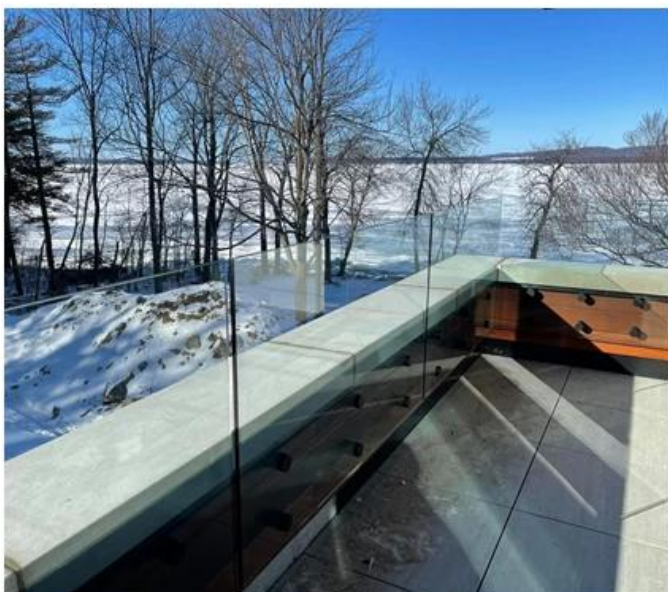
Stanik ze stali nierdzewnej do bezramkowej balustrady szklanej
