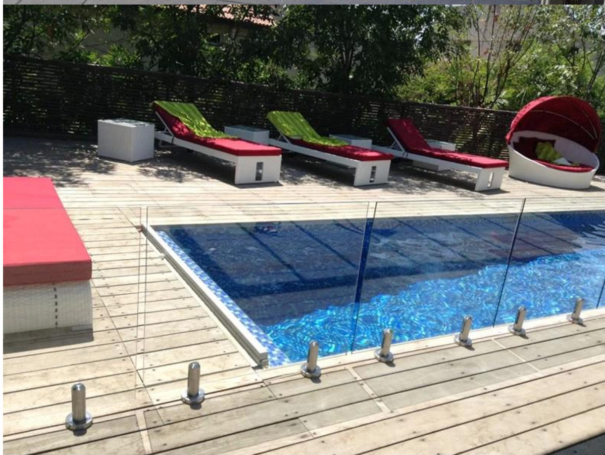
balustrady ze szkła kwadratowy czop płyty szklanej podstawy
