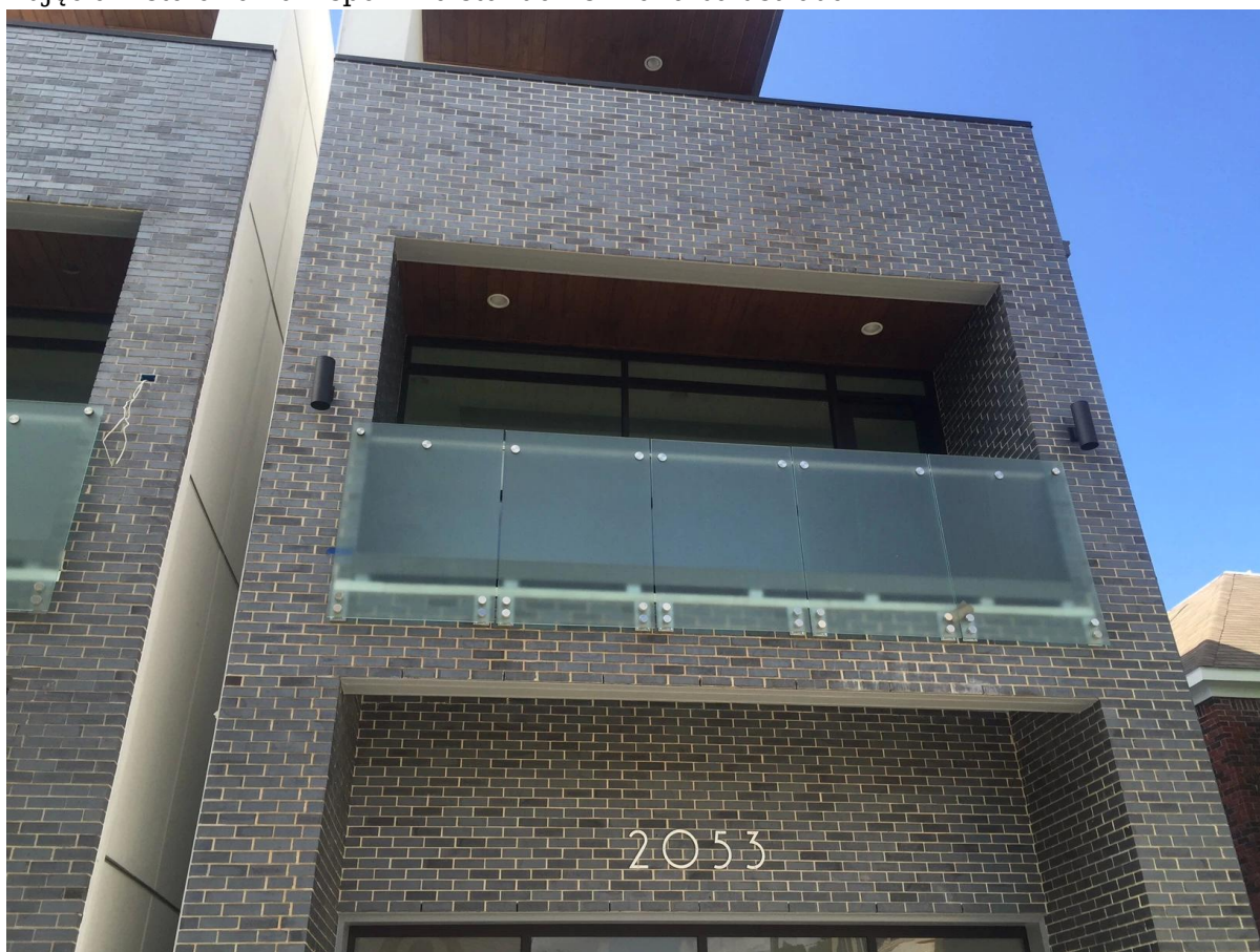
Zdjęcia instalowania wspornika standoff szklana balustrada
