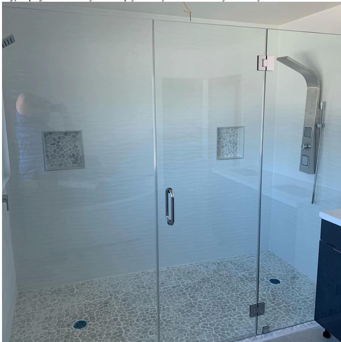
Zdjęcia projektowe szklanych drzwi prysznicowych z zawiasami hydraulicznymi
