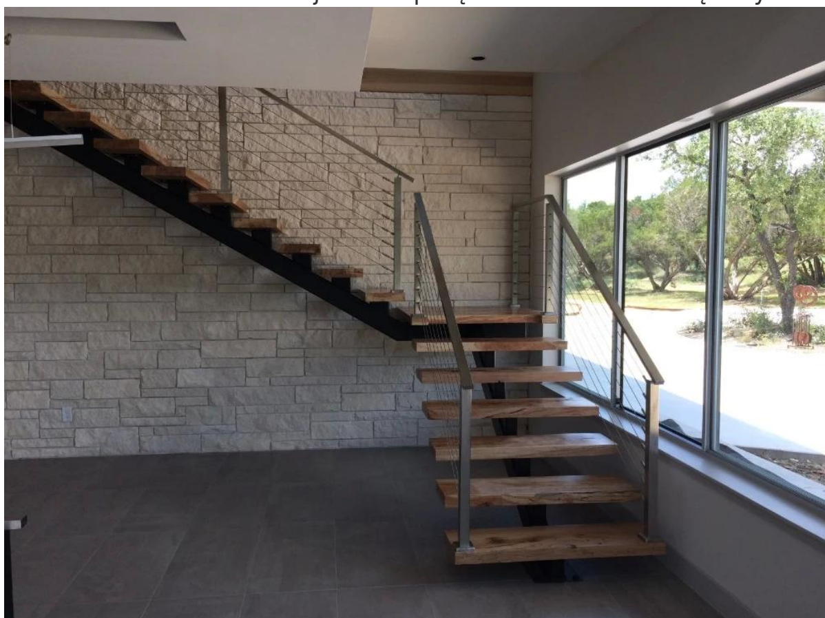
stal nierdzewna konstrukcja kabla poręcze schodów wewnętrznych
