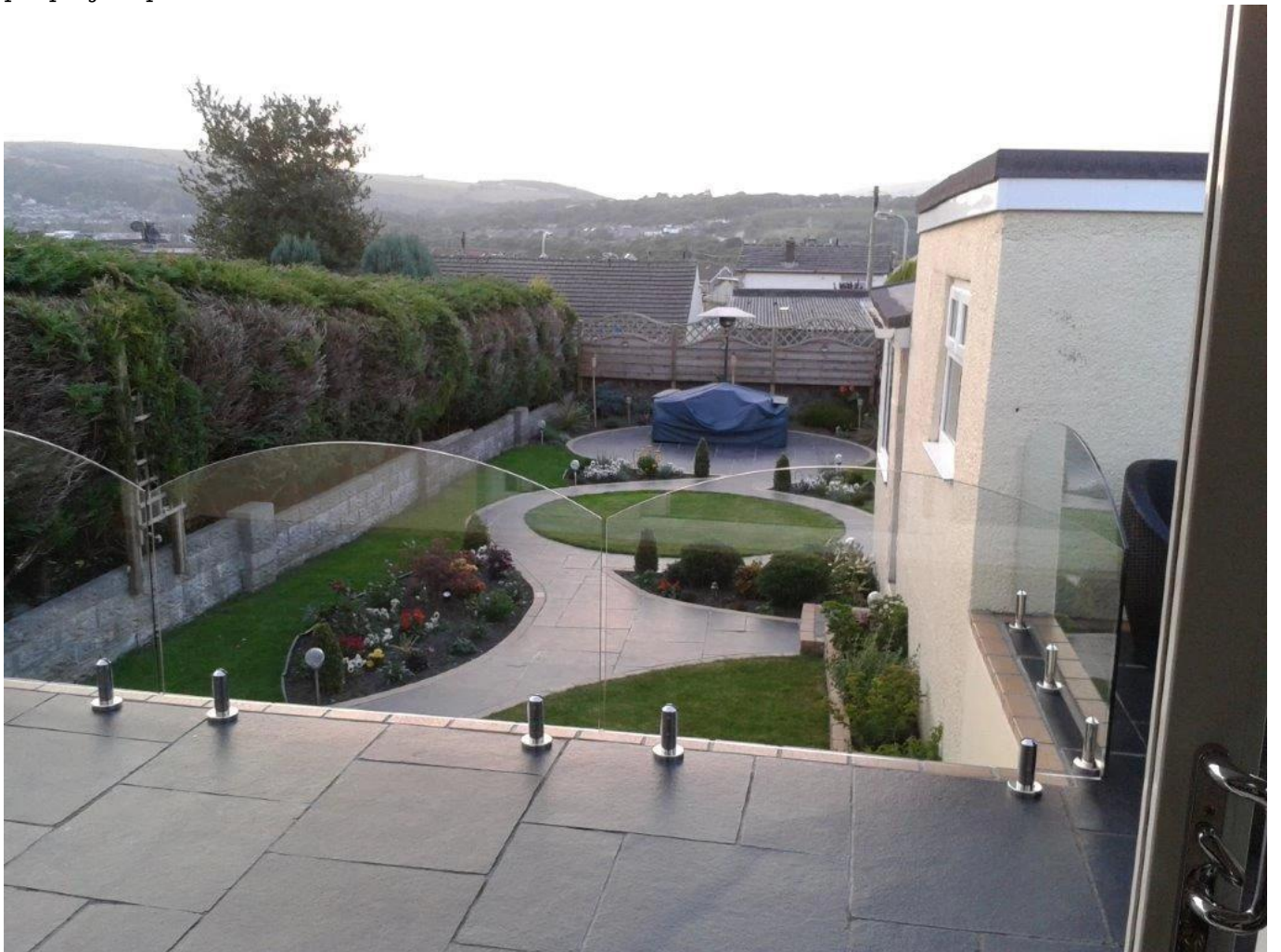
pic projeto para balastrada de vidro com torneira de vidro
