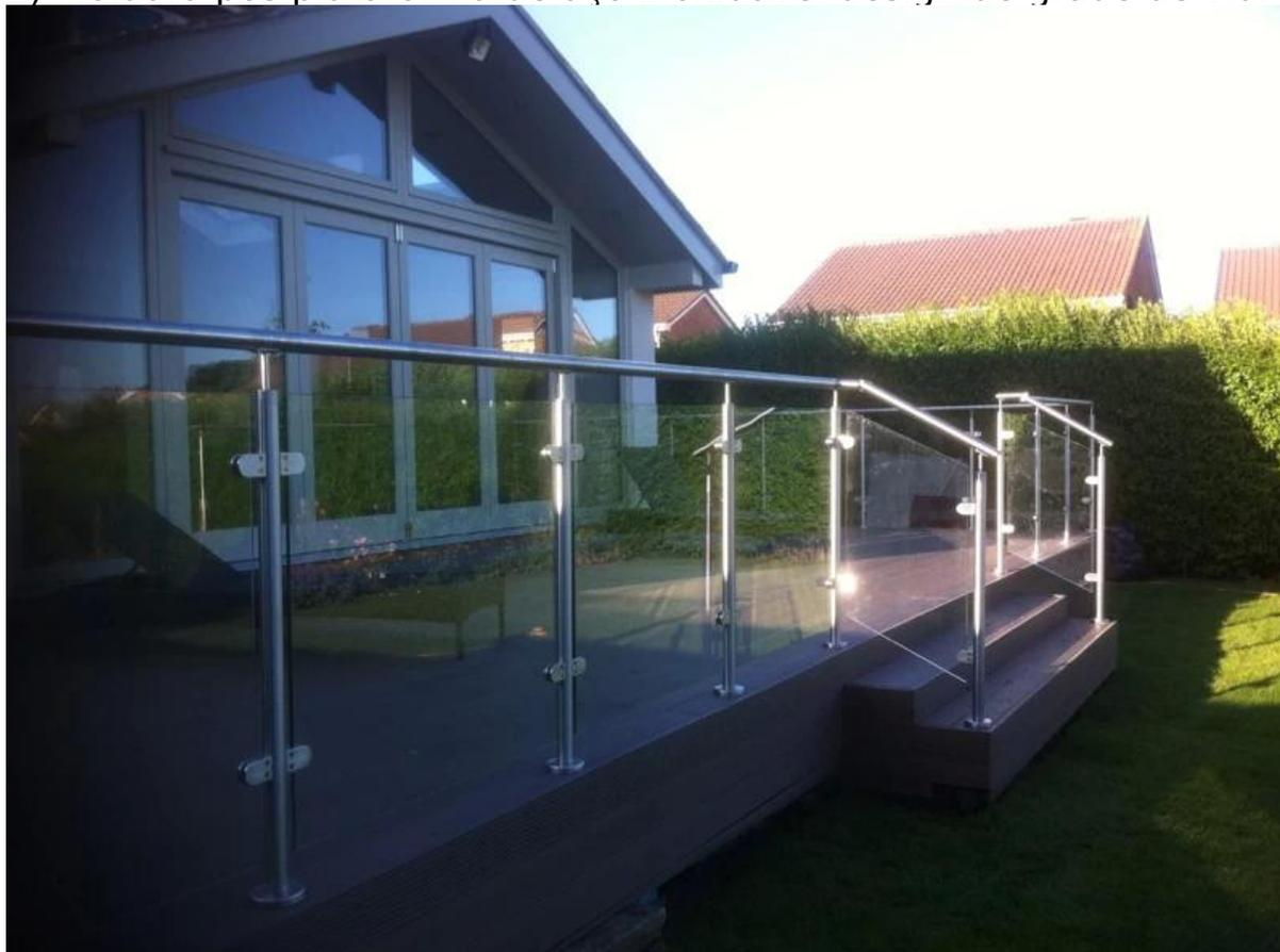
3) Semi-frame pós plataforma de aço inoxidável design de grade de vidro,
