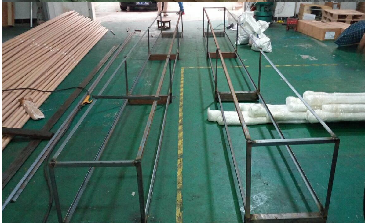
Fotos de instalação de tubo de slot 20x25mm aço inoxidável 316L para vidro de 12mm
