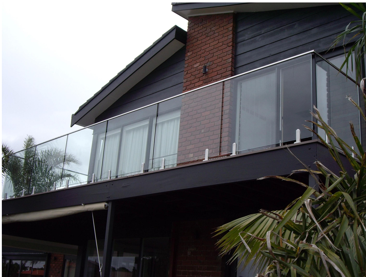
Foto instalação de Aço inoxidável 316 slot superior corrimão 21x25mm dentro de casa
