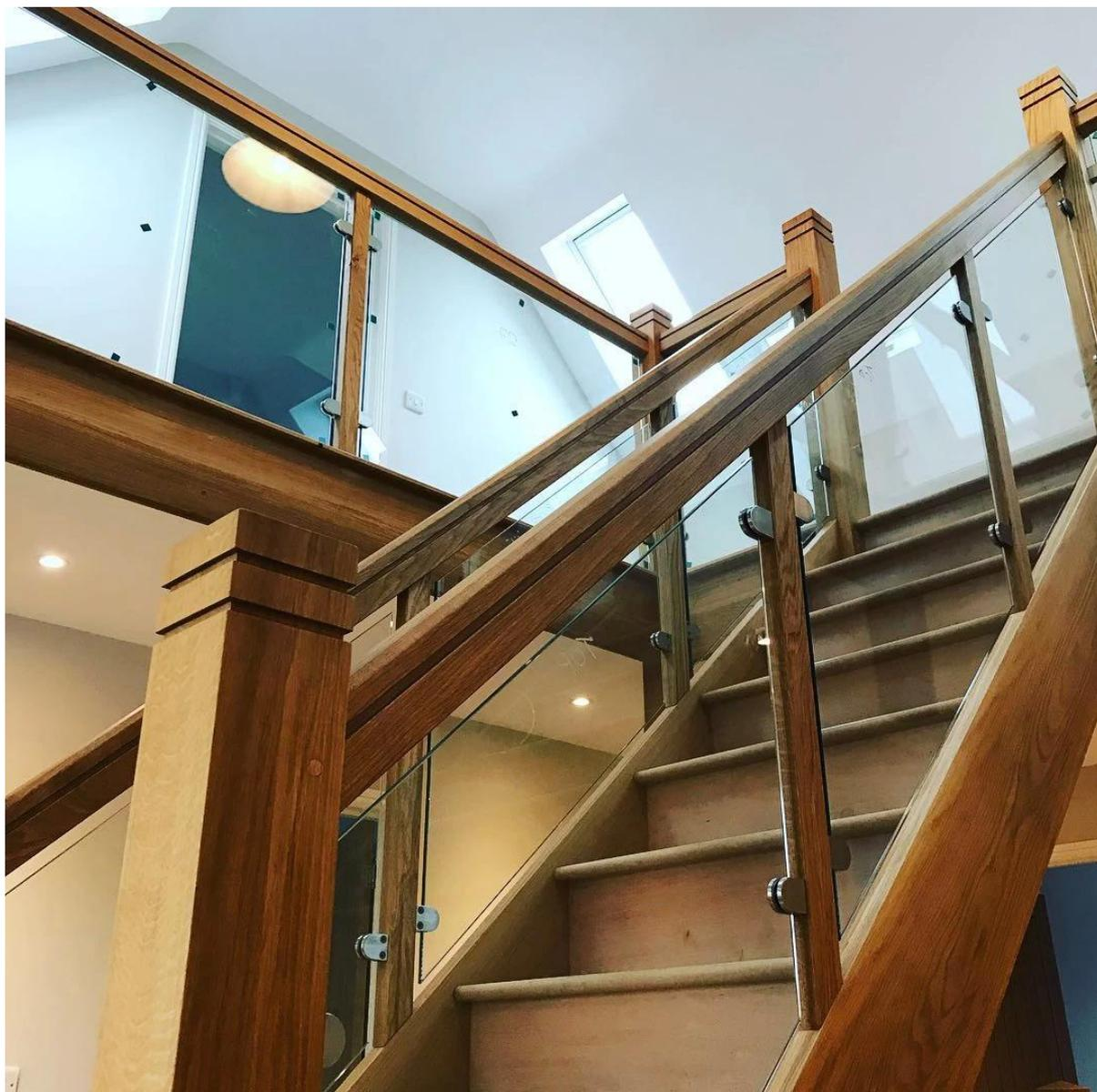
o grampo normalmente usado com poste de aço inoxidável para segurar painéis de vidro, para corrimão de varanda, corrimão de terraço, escada. Adequado tanto para portas internas quanto externas.
