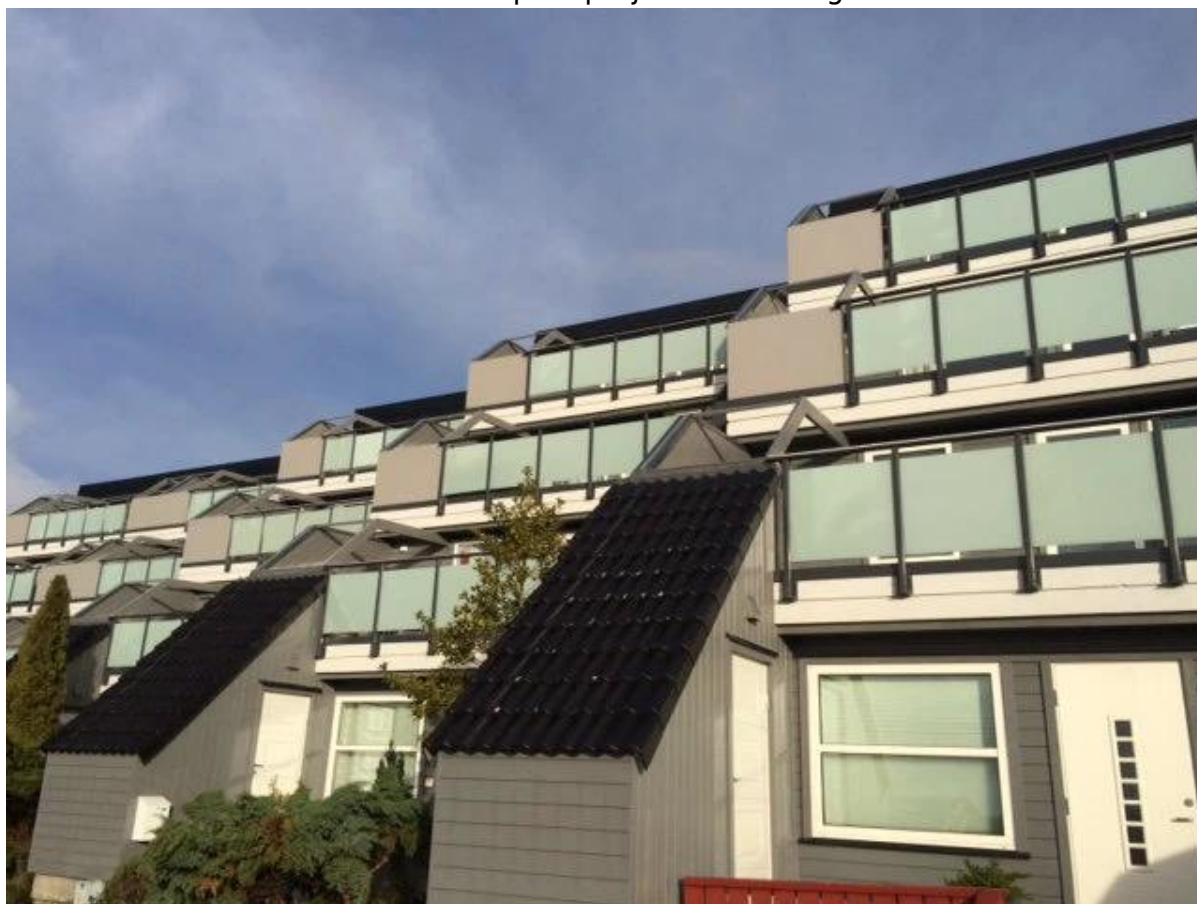
Montada lateral alumínio corrimão post project na Noruega
