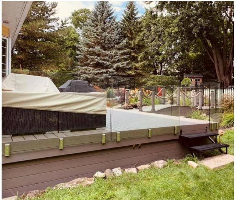
Spigot de vidro da placa de vidro da placa de montagem do assoalho
