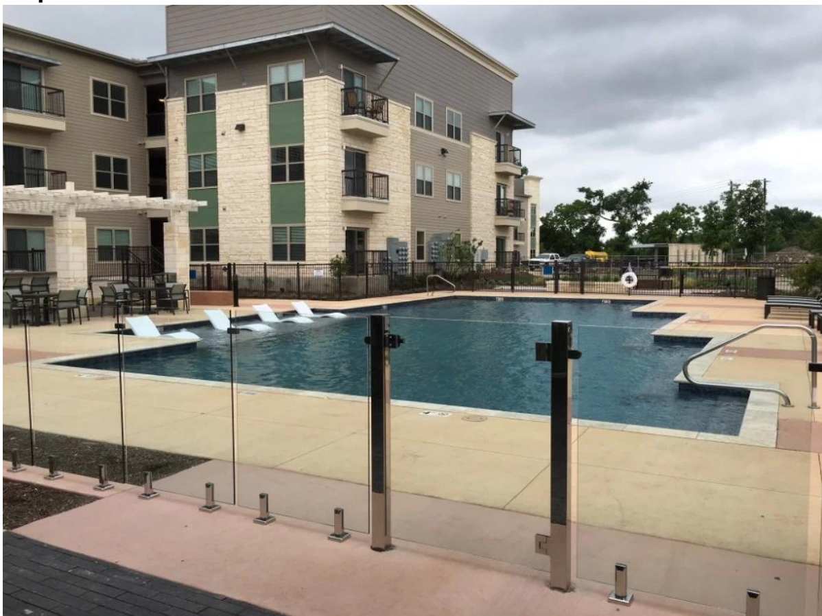
Projeto de balaustrada de aço inoxidável de 50x50 para esgrima da piscina:
