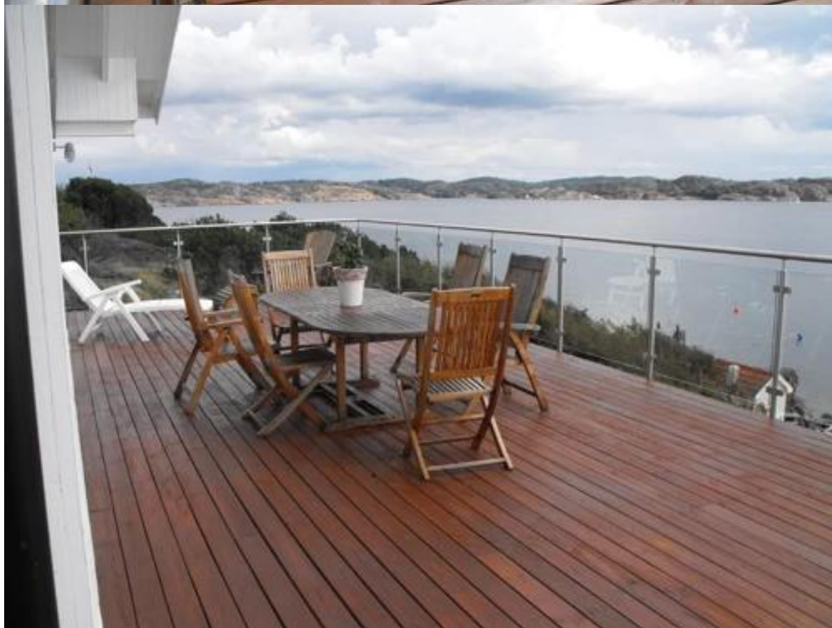
Poste montado lateralmente
