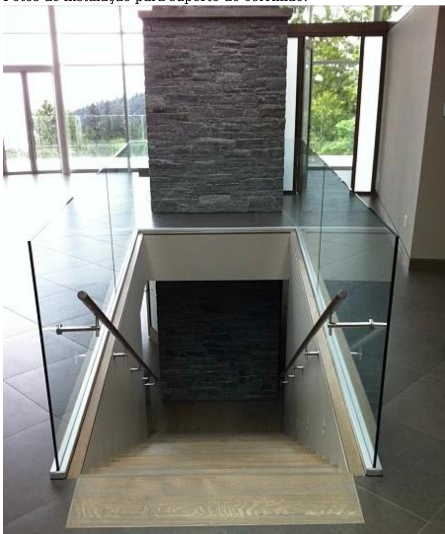
Fotos de instalação para suporte de corrimão:
