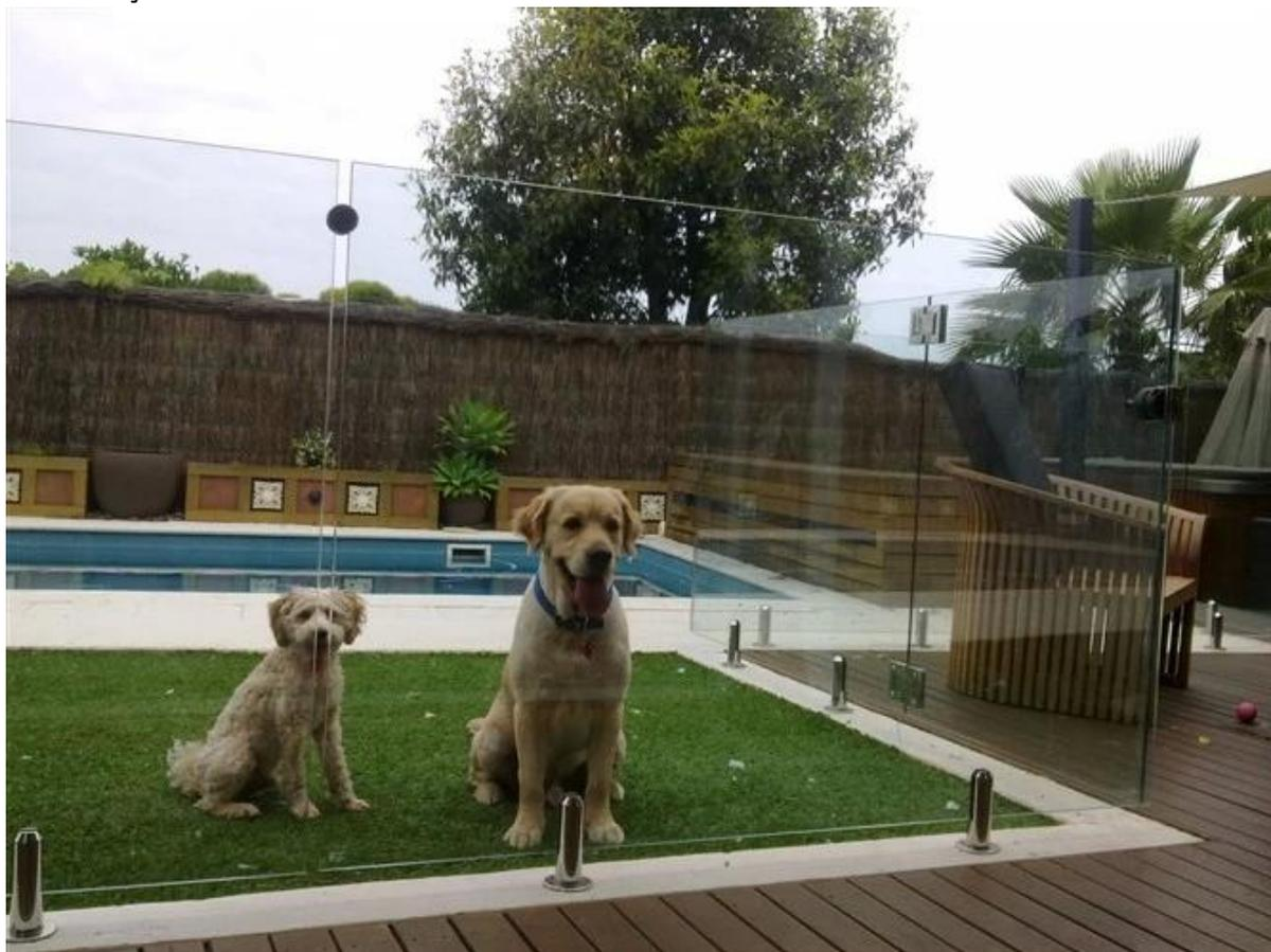
Vidro braçadeira de reforçar a sua vedação de vidro, conecta 2 painéis de vidro como um, protege a sua vedação em caso de quebrado pela força.
