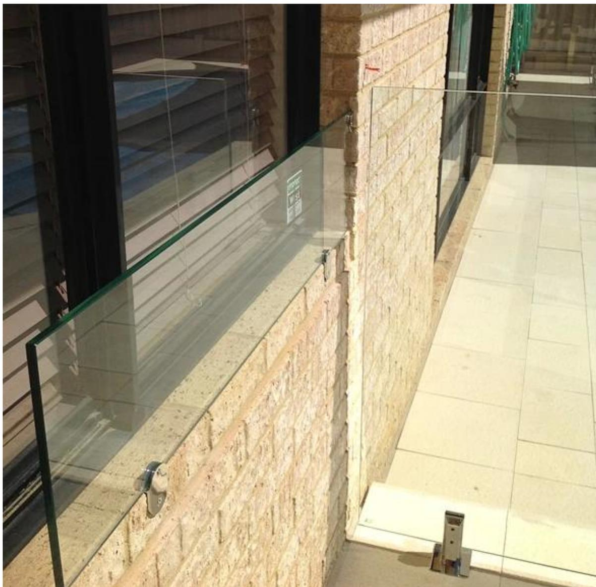
Como CB-180 não é muito grande, não poderia ser usado se o seu vidro de janela é de grandes dimensões, de qualquer maneira, nós podemos adicionar braçadeiras de vidro nas laterais, ou você pode usar nossa torneira de vidro na parte inferior;
