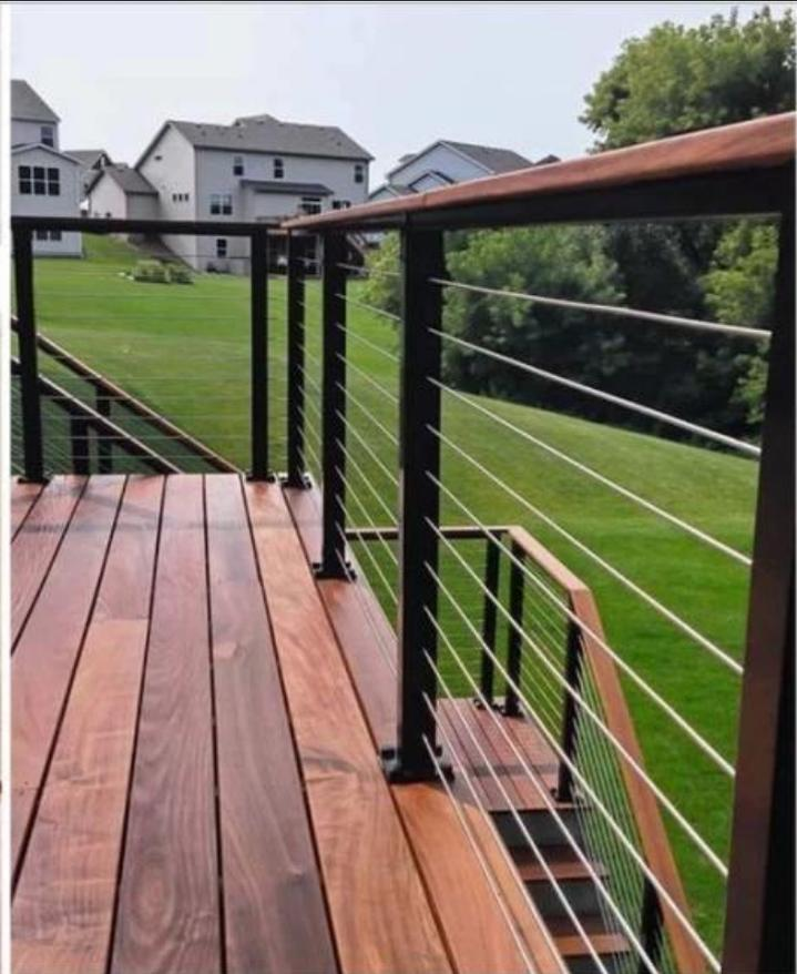
**O tipo de aço inoxidável 316 tem a melhor resistência à corrosão entre os aços inoxidáveis padrão. Resiste ao pitting e à corrosão com a maioria dos produtos químicos e é particularmente resistente à corrosão de água salgada.**
