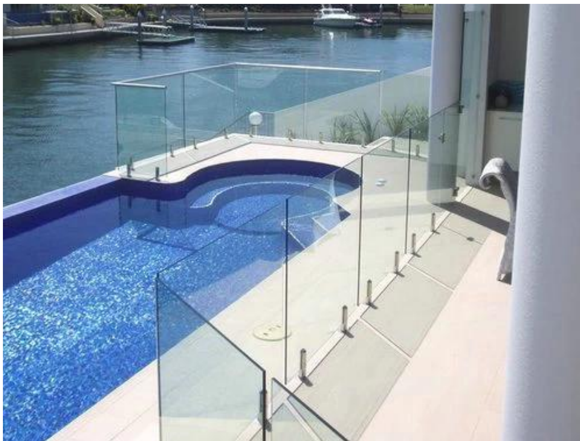
sistema de vedação de vidro, incluindo: torneira de vidro, dobradiça, trava, vidro temperado
