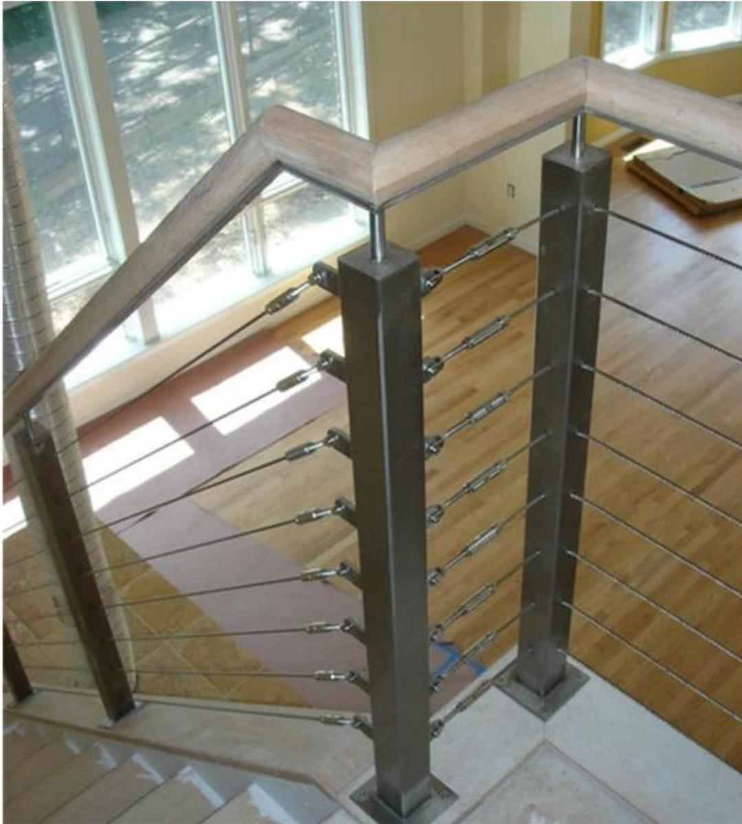
Existem vários tipos de tensores de cabo de aço para a sua escolha. Bem-vindo para nos enviar o desenho da escada yoru. Nós somos o fornecedor one-stop. Este é Susie Fu ^. ^ Bem-vindo a contactar-me.✘
