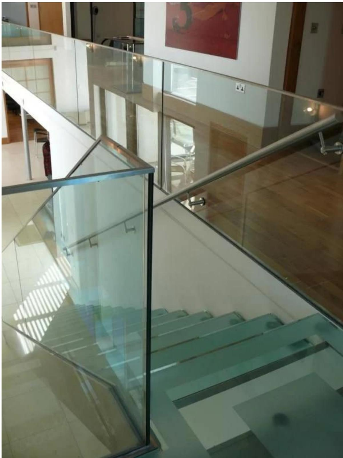
3). modelo No.P707 parede de aço inoxidável caixa da escada de vidro montada suporte de corrimão
