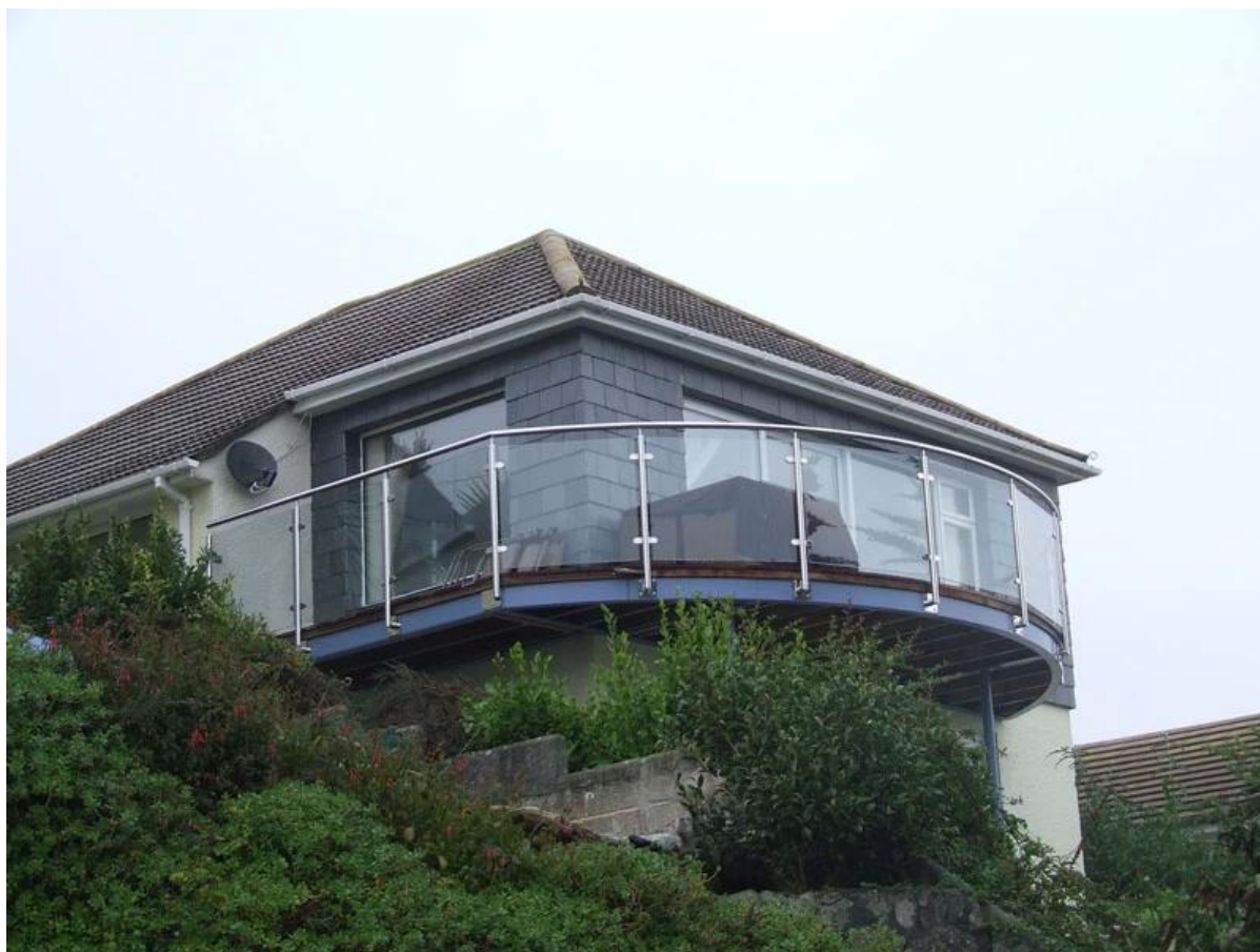
grade varanda projeto 1.200 milímetros de alta para edifício residencial
