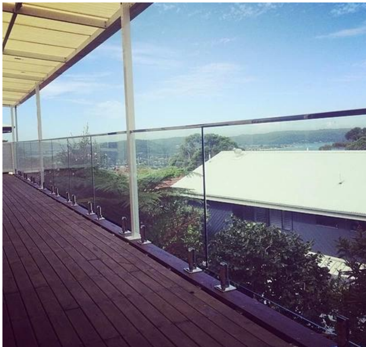
4. balaustradas de aço inoxidável redondo diâmetro 25,4 mm trilhos superiores,
