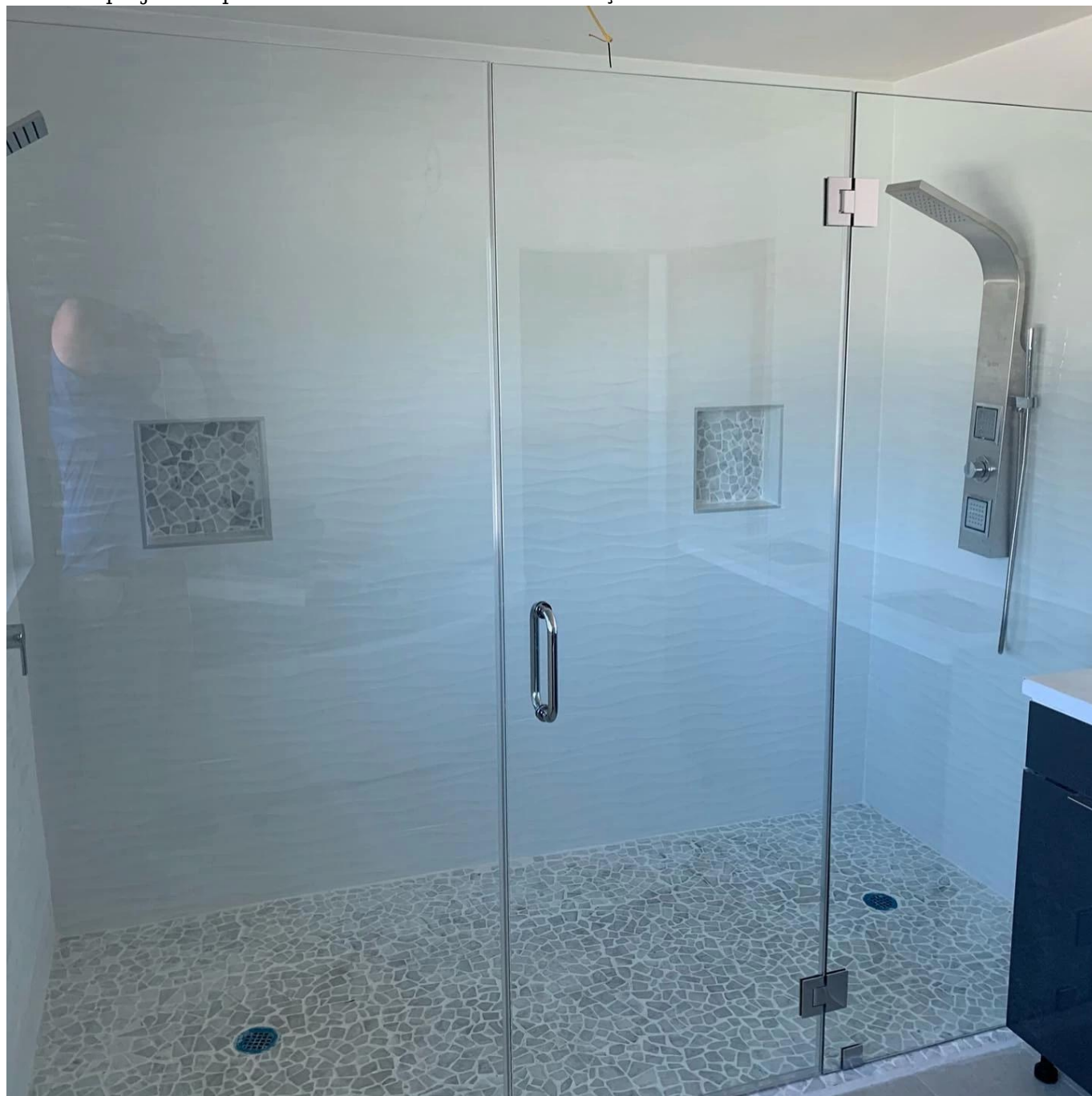
Fotos do projeto de portas de box de vidro com dobradiças hidráulicas
