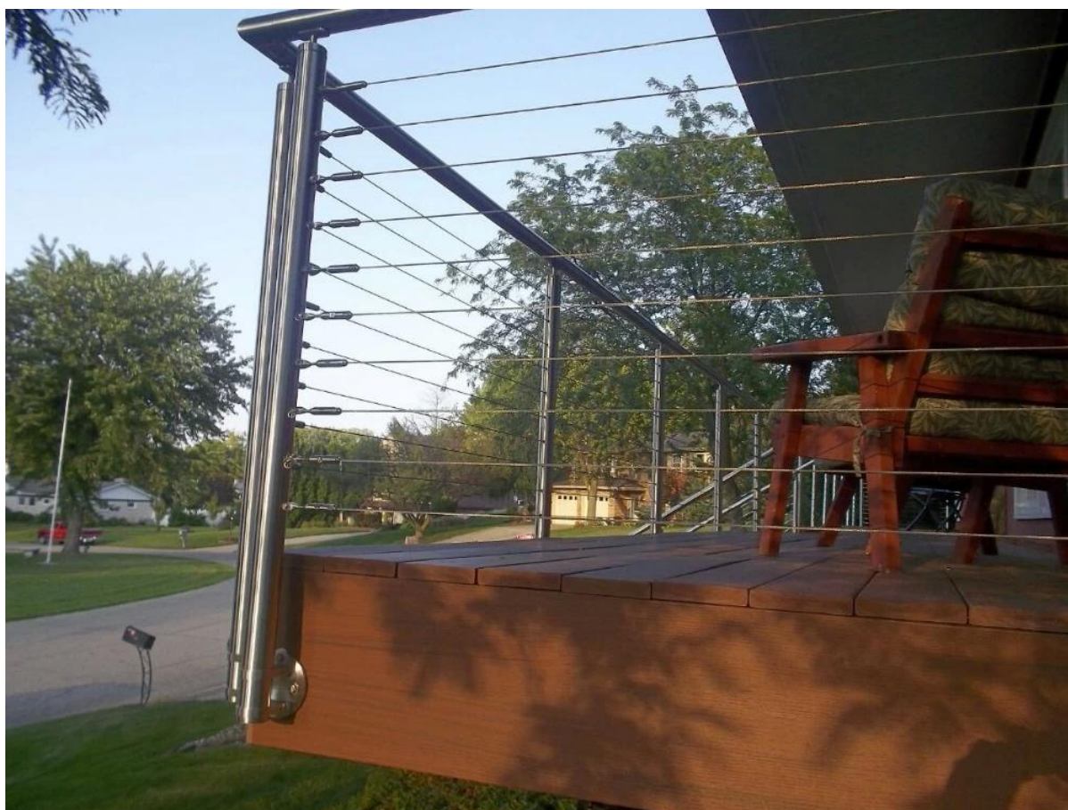
3. Forma quadrada do projeto de aço inoxidável pós cabo trilhos: projeto de cabo trilhos de aço inoxidável para o deck ao ar livre,
