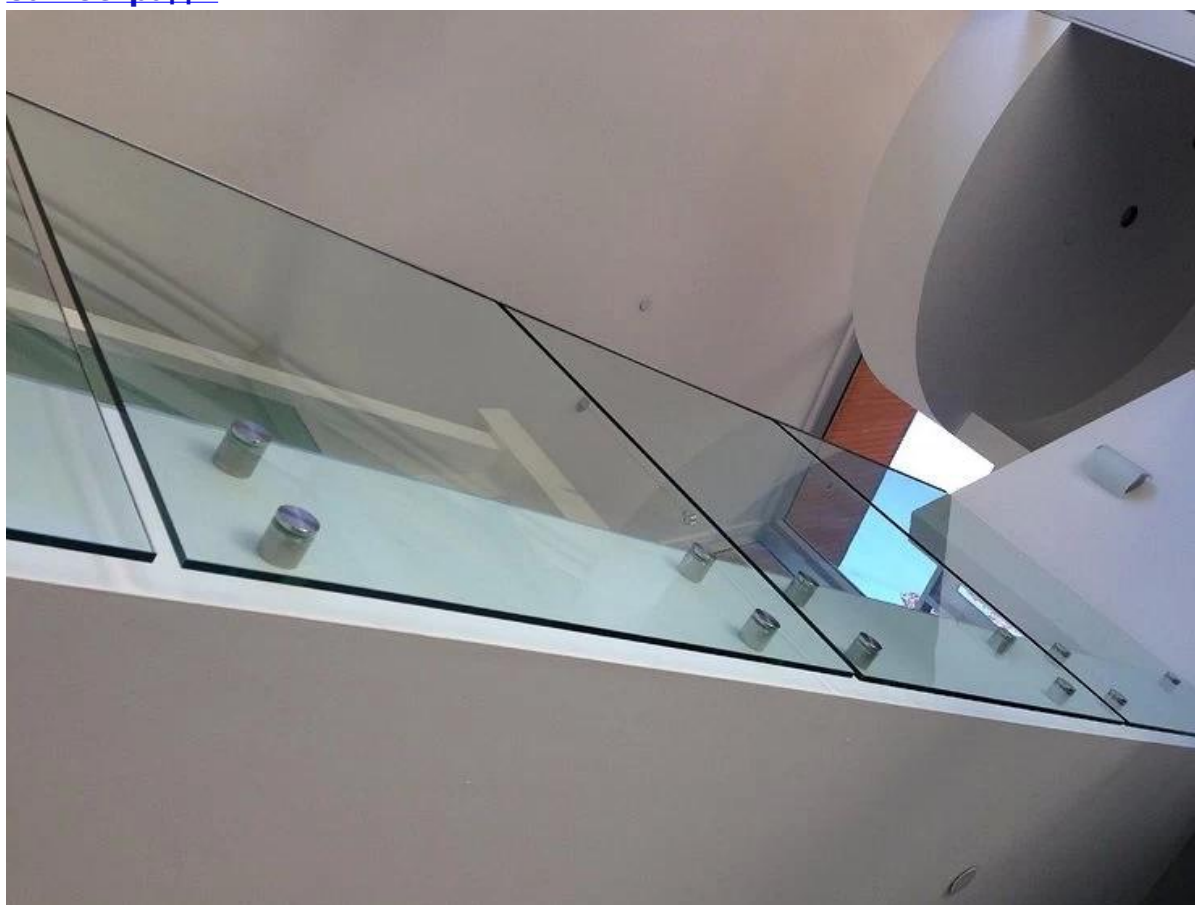
стойка из нержавеющей стали, кронштейн для стеклянных панелей, конструкция перила
