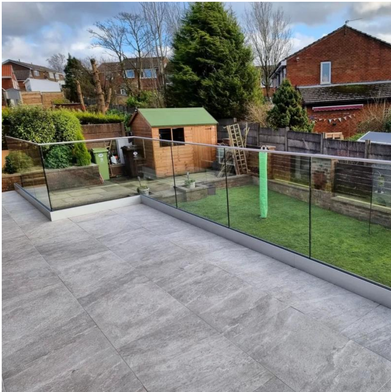
Безрамная балюстрада, алюминиевый U-образный профиль, стеклянные перила, оборудование
